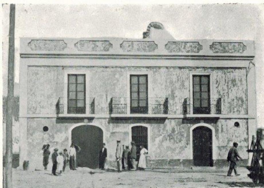
Fábrica de Salazones y Conservas de Pescados José Soler y Barcia
