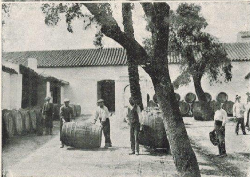
1, Bodega de soleras viejas. 2, Patio de las bodegas de la Encina.
