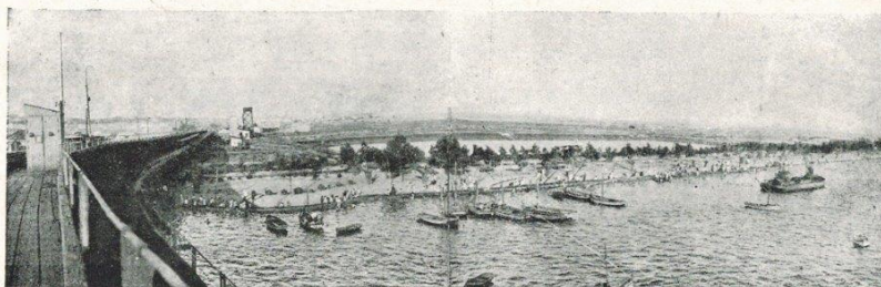
Vista panorámica de los terrenos marcados con cuadrícula en el plano general.
